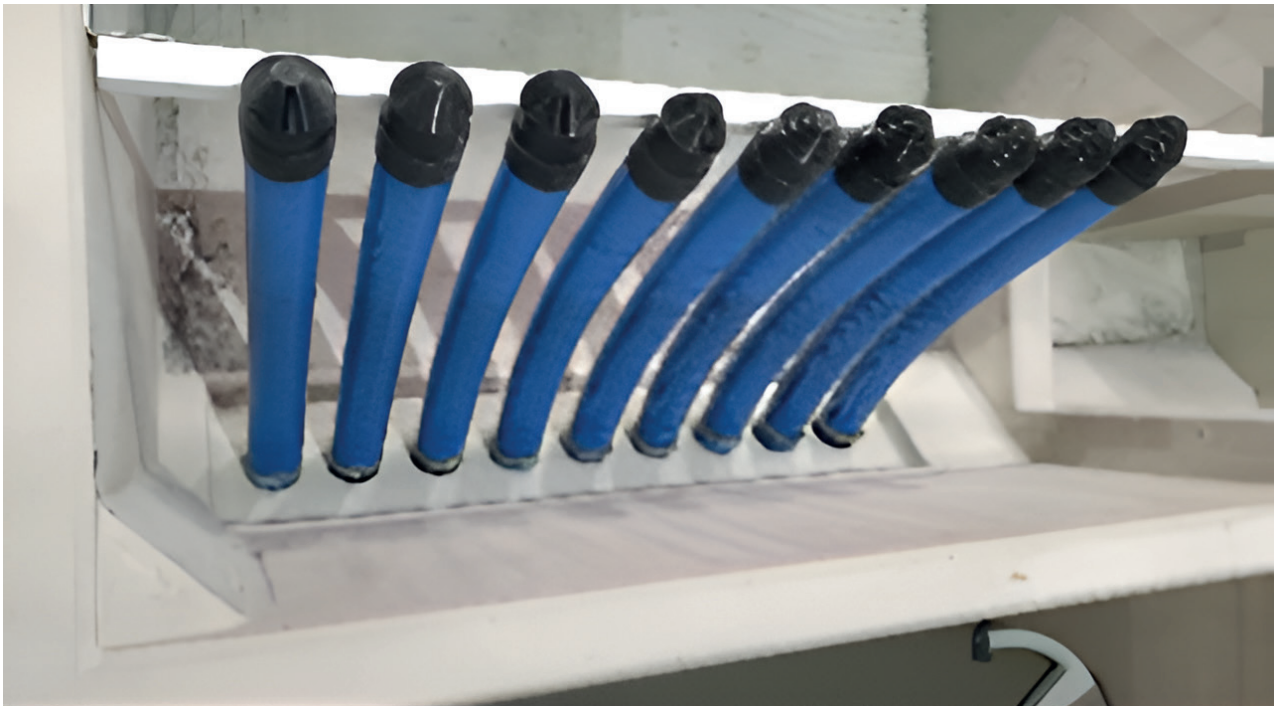
↓ Afbeelding 6. ingestorte slangtules in compactstation.
